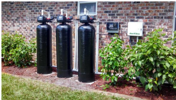
實際案例一：三閥三罐
